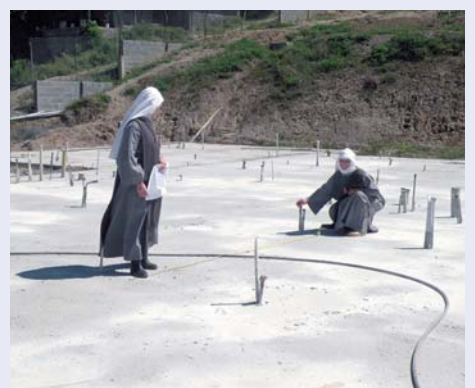
Poser les fondations : dans la prière, elles ont reçu l'assurance que le chantier continuerait.
